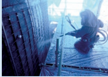
橋脚耐震補強
