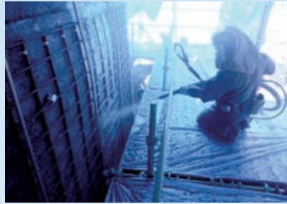
橋脚耐震補強
